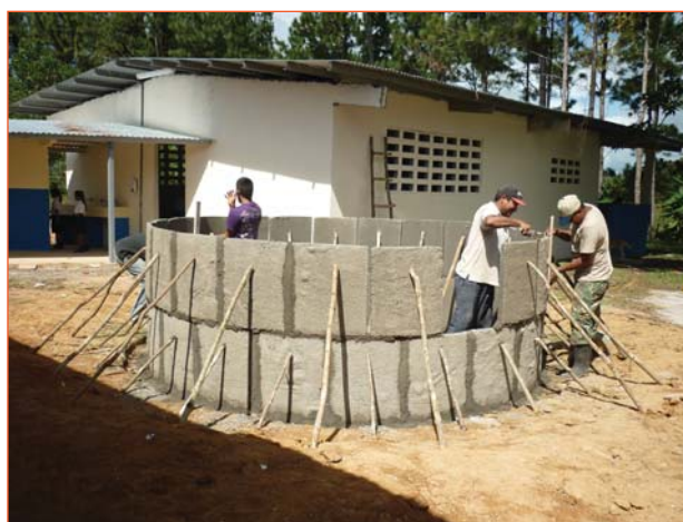
Construcción de tanque para cosecha de agua en Luisa de Olá.
