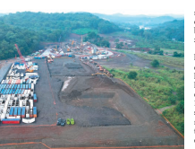
Complejo Industrial de Farfán, donde se guardará y controlará el punto de ataque por donde ingresará la tuneladora Panamá.
